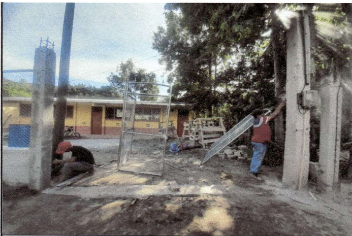
Foto 3: SE ESTÁ INSTALANDO EL PORTON DE INGRESO DE LOS ESTUDIANTES.
