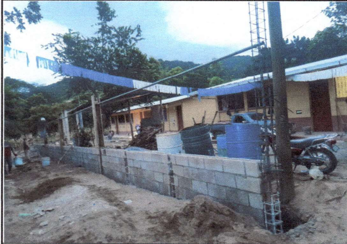
Foto1: SE ESTÁ REALIZANDO EL MEJORAMIENTO DE CERRAMIENTO DEL MURO PERIMETRAL.
