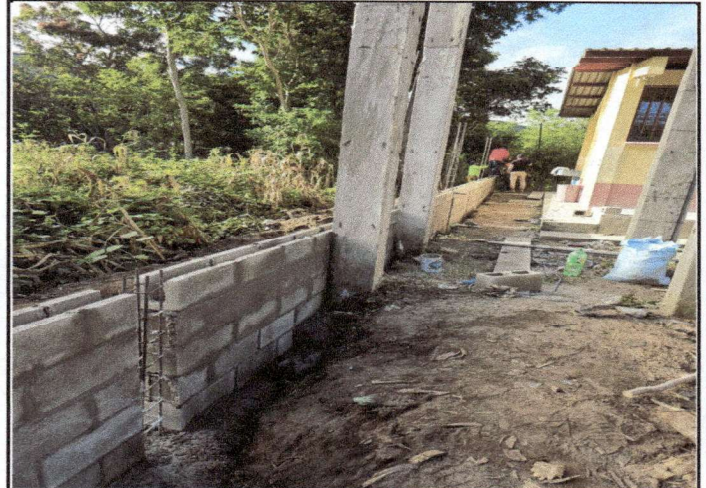
Foto 2: SE ESTÁ REALIZANDO EL MEJORAMIENTO DE CERRAMIENTO DEL MURO PERIMETRAL.
